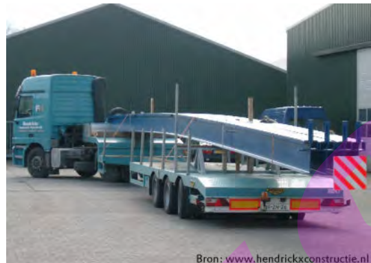
Stalen spanten op transport
