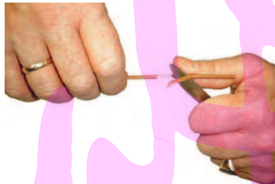
De isolatie schuin insnijden tot het einde van de draad
