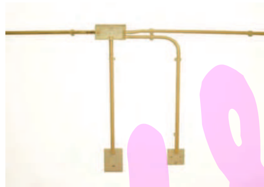
Installatiebuizen
