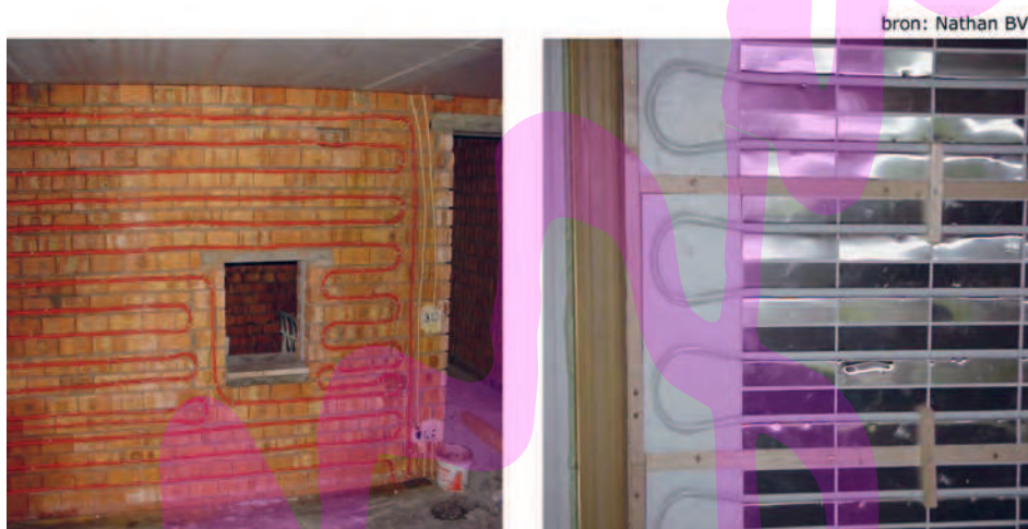
Enkele voorbeelden van wandverwarming
