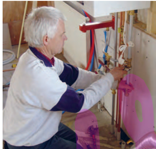
Gas- en cv-leidingen aanleggen
