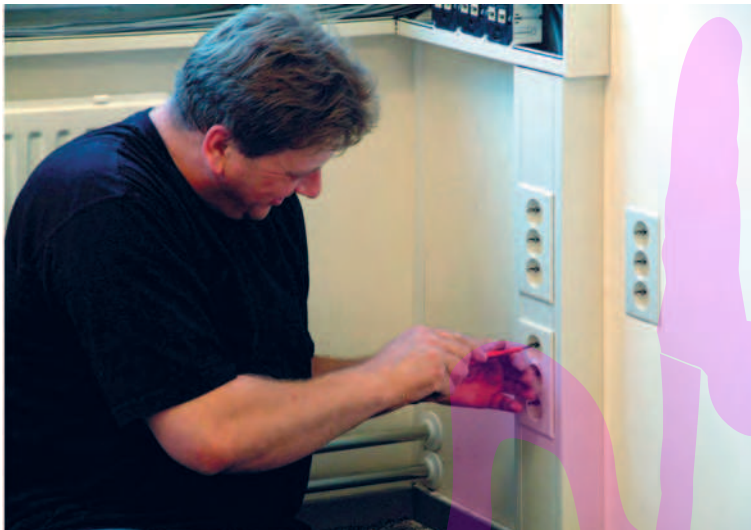
Werken in de utiliteit
