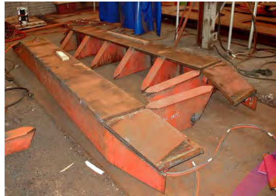
Motorfundatie van kustvaarder in aanbouw
