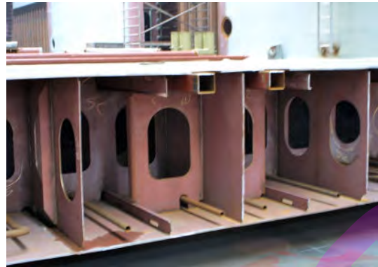
Dubbele bodem in aanbouw
