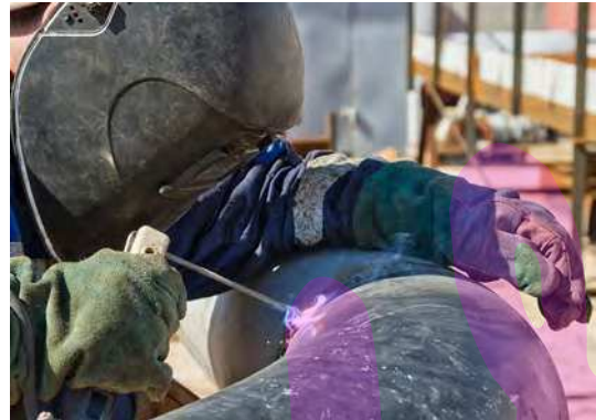
Booglassen met beklede elektrode
