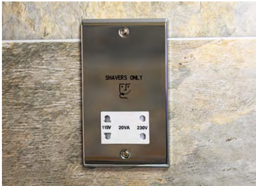
Scheerwandcontactdoos met een beschermingstransformator
