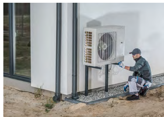
Visuele inspectie van een buitenunit
