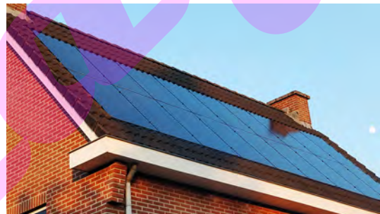
PV-panelen in het dak geïntegreerd
