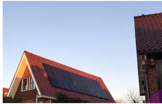
Schaduw op de PV-panelen
