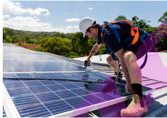
Aanleggen van een PV-installatie
