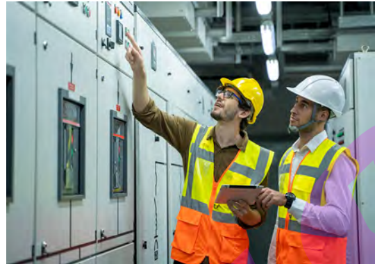
Werken aan laagspanningsinstallaties
