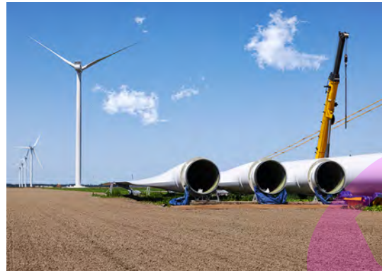
Rotorbladen liggen klaar voor montage
