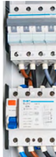
Installatieautomaat 3P+N (boven) en I_{\Delta n} 30 mA-aardlekschakelaar (onder)
