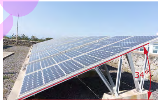
Optimale positie op een plat dak
