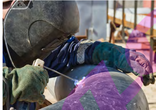
Booglassen met beklede elektrode (BMBE)
