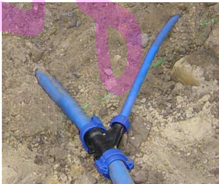
Afbeelding 5. Waterleiding in de grond
